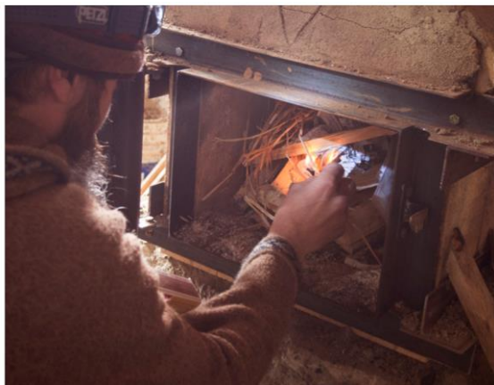
Версия с горизонтальной загрузкой, где дверь вмурована в саман в Хомере, Аляска.
