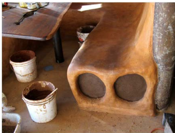
Дальние концы дымохода, там, где он сворачивается вдвое, с выгребными окошками.
