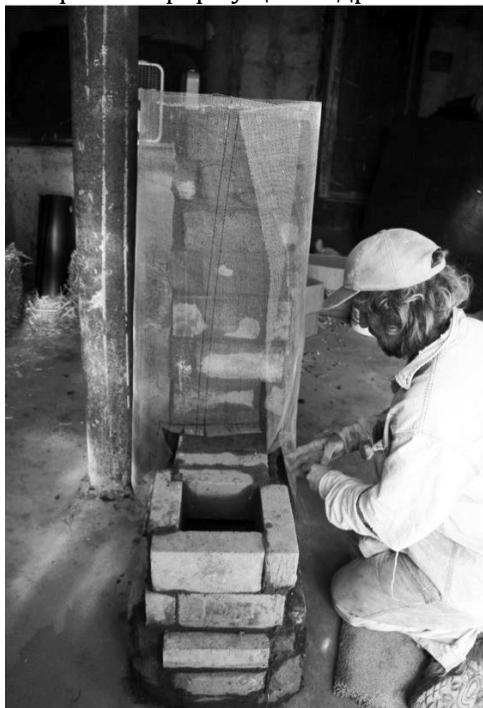
Арт Людвиг делает контейнер для изоляции из сетки вокруг кирпичной внутренней трубы.
